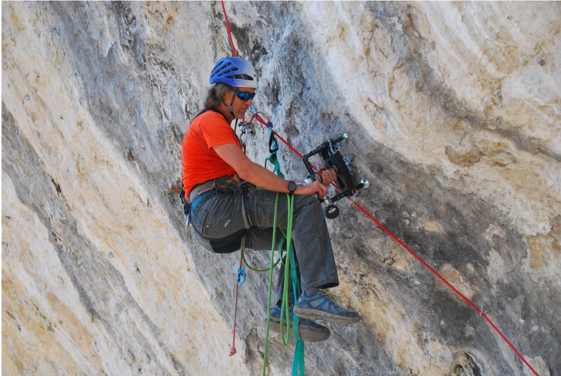
Comprobando la resistencia de los anclajes (parabolts)
